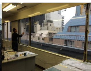
【土志田事務所ビル】
