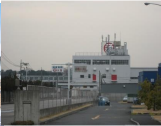
【イトーヨーカドー埼玉物流倉庫】
