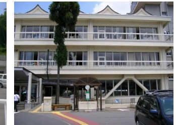
【長野県須坂市役所】
